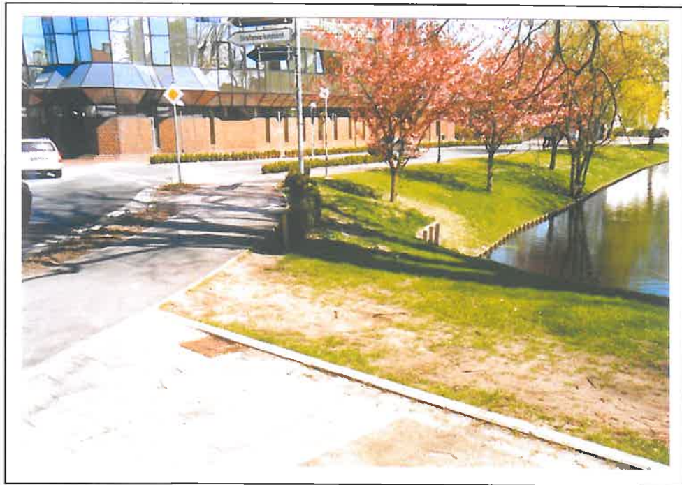
Abb. 8.3-24 Pferdegriaf. Nach Umbau des Kreuzungsbereiches Schillerstraße / Elisabethufer. Fahrbahn und Bürgersteig wurden in Richtung der Griaf verbreitert. Mit neuer Holz-Stützmauer und neuer Buchs-Pflanzung. (Foto, April 2004.)
