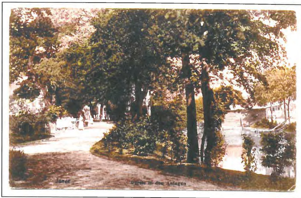
Abb. 8.3-2 Partie in den Anlagen. 1909. Blick vom Königsdamm. Die Gracht reicht am nördlichen Ende direkt bis an das Mettcker'sche Grundstück an der Wangerstraße. (PK 121. Schloßmuseum Jever.)
