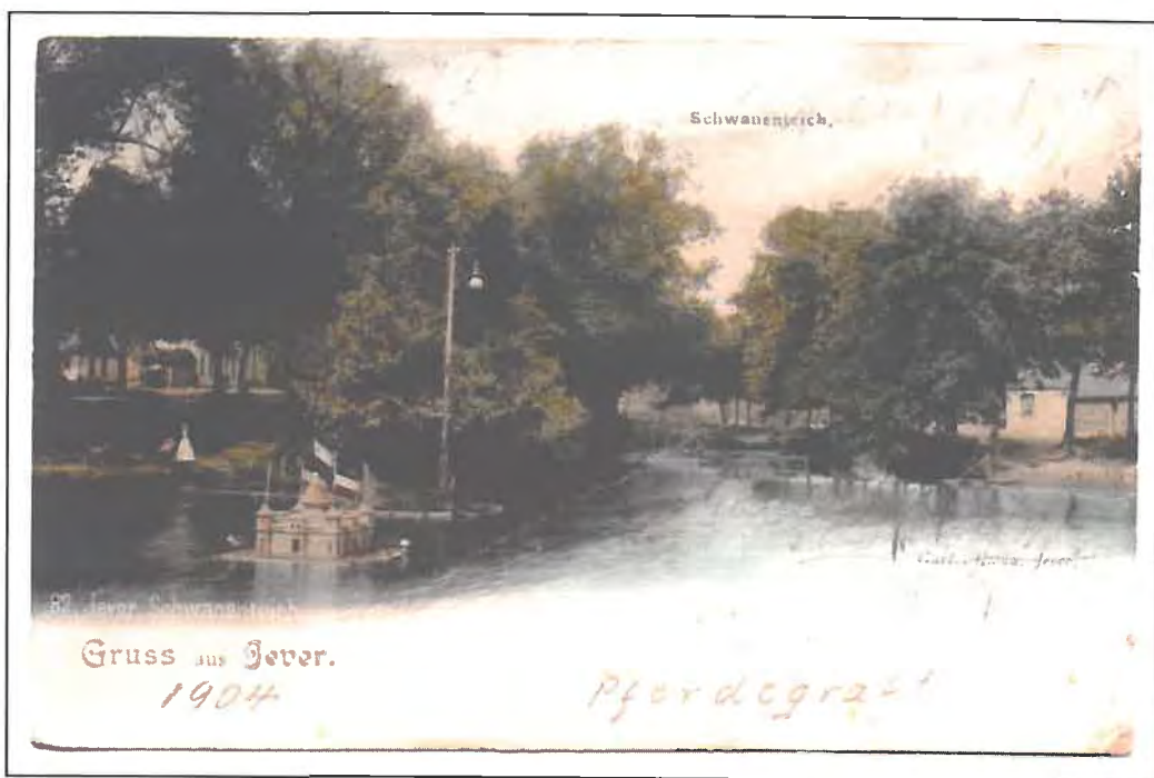
Abb. 8.3-12 Pferdegruft von Osten gesehen. 1904. Rechts das Elisabethufer mit Allee und ehemaliger Einfahrt in die Pferdeschwämme. Links das Entenhaus. (PK 116. Schloßmuseum Jever.)
